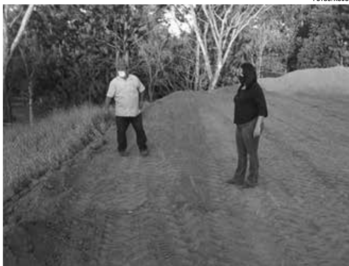
Local onde começaram as obras para o viveiro municipal
