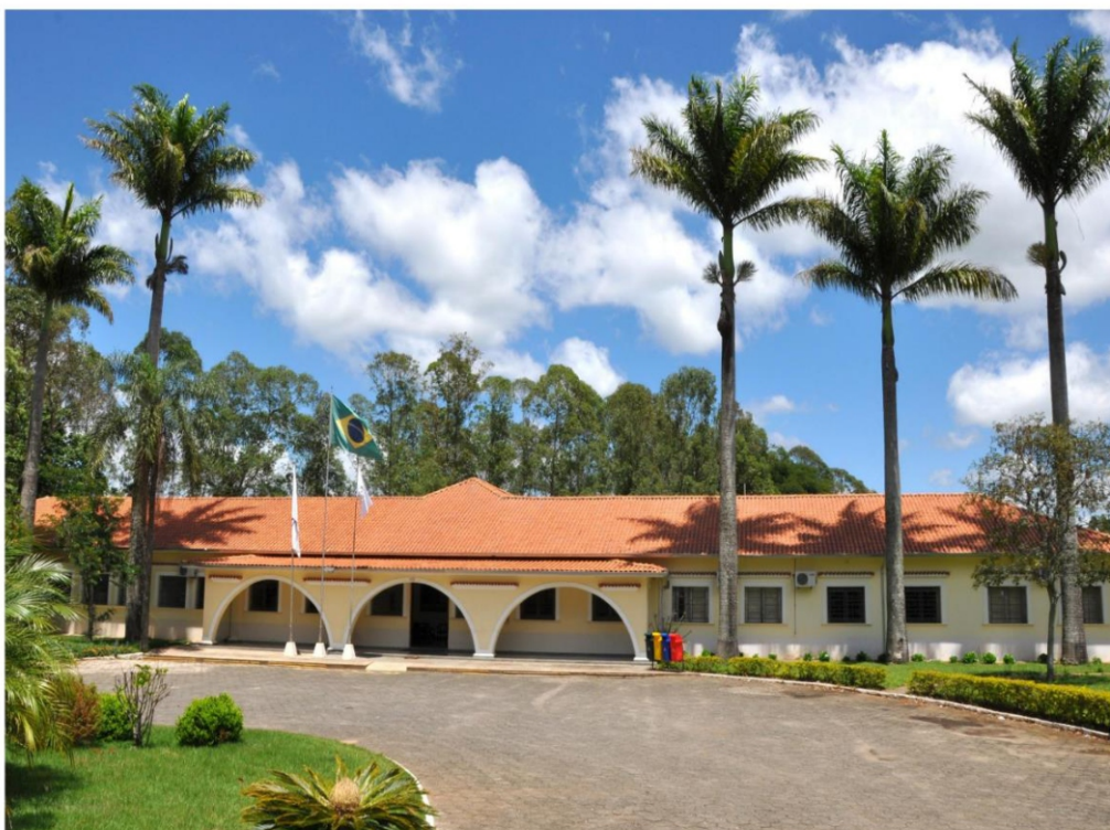
Figura 05 - Prédio Administrativo do Campus Muzambinho
