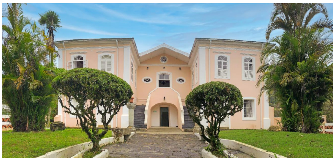
Figura 17 - Antigo Casarão reformado do Campus Avançado Carmo de Minas
