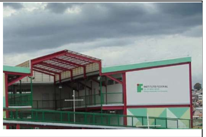
Figure 8: Campus Três Corações natural ventilation and lighting.
