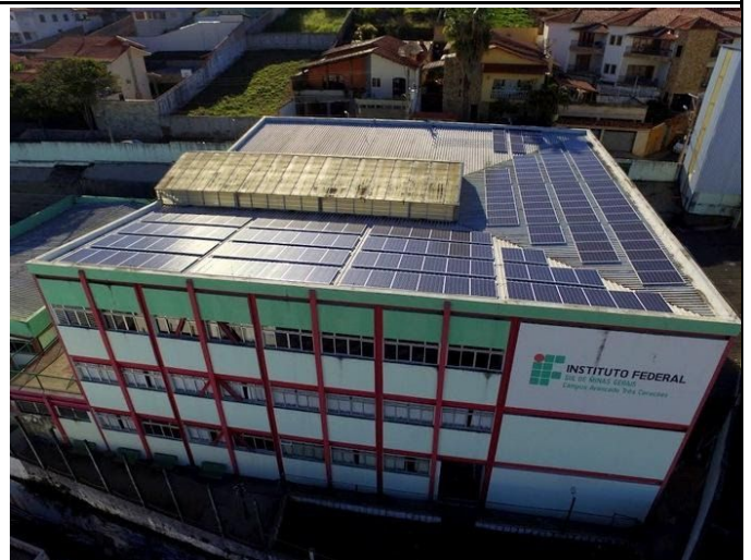
Figure 8: Campus Três Corações solar power plant.
