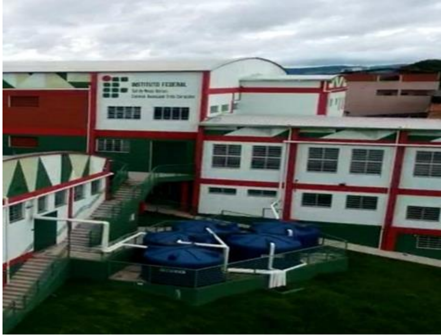
Figura 9- Estação de coleta de águas pluviais (Campus II).
