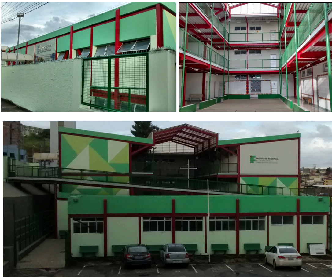
Figura 7 - Fachadas do Bloco Pedagógico (Unidade II)
