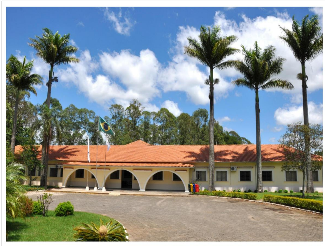
Figura 05 – Prédio Administrativo do Campus Muzambinho
