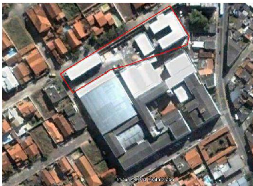
Figura 5 - Vista aérea das instalações do Campus Avançado Três Corações
