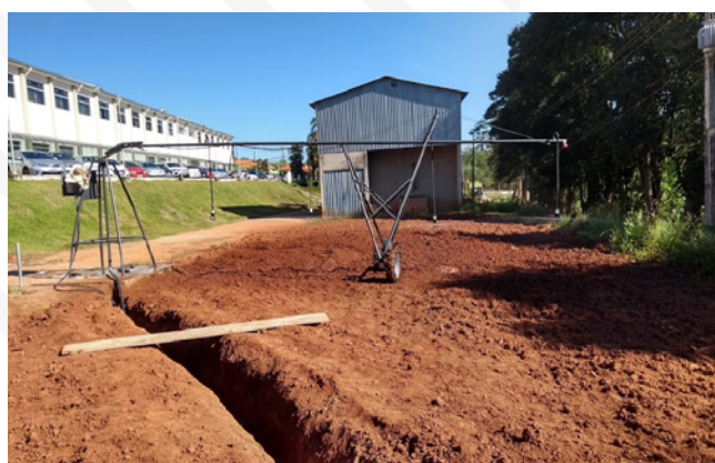
Figura 4: Montagem definitiva do pivô na área a ser irrigada.
