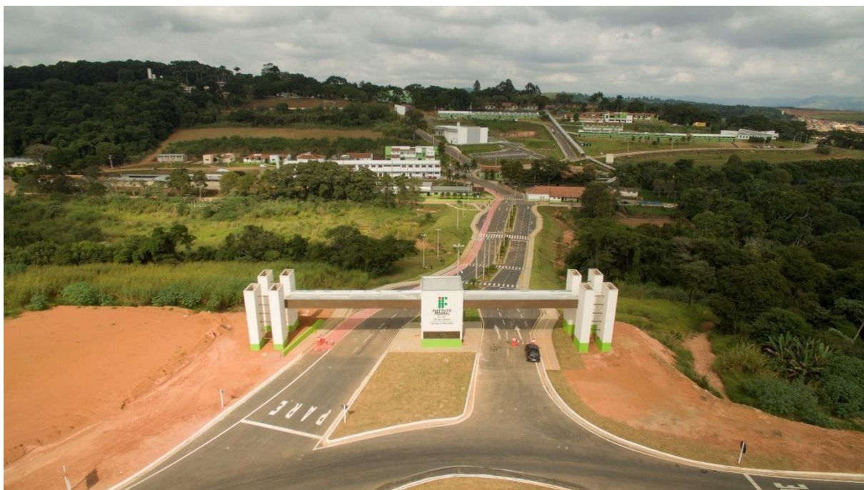
Figura 2. Entrada do IFSULDEMINAS Campus Machado, Rod. Machado/Paraguaçu em Machado/ MG.
