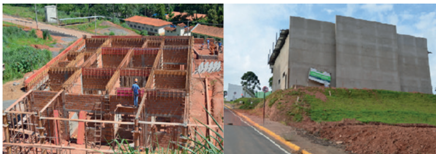
Figura 34 – Novo auditório: em construção e com a obra quase finalizada
