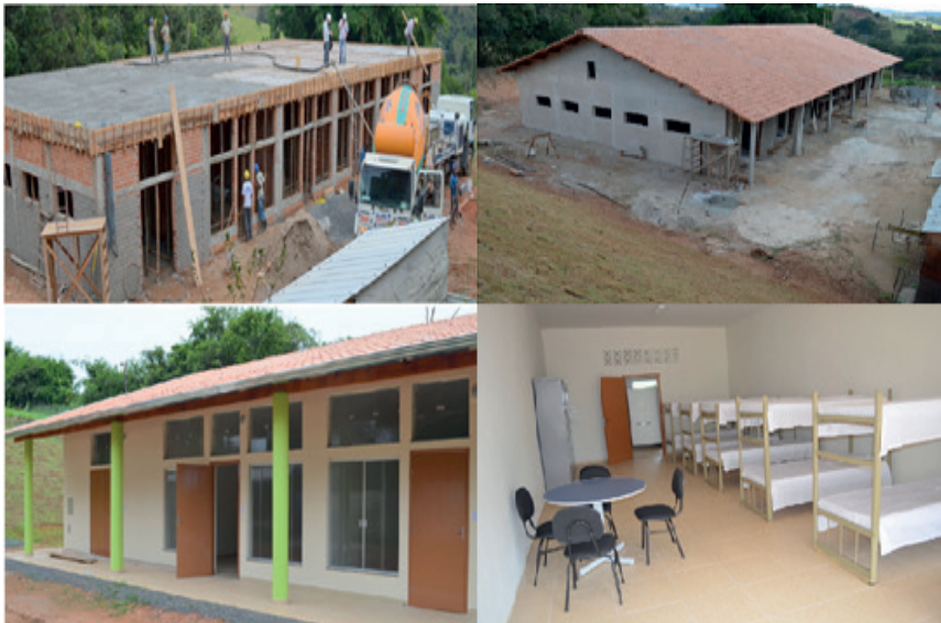
Figura 35 – Novo Alojamento feminino: etapas da construção
