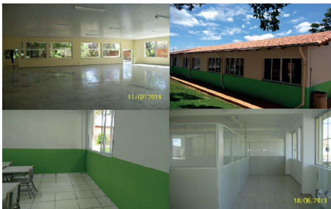
Figura 42 – Obras no Campus Passos
