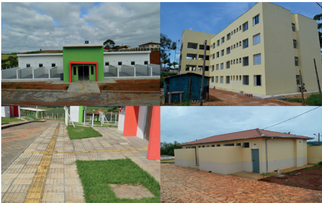
Figura 39 – Algumas das obras no Campus Muzambinho 26
