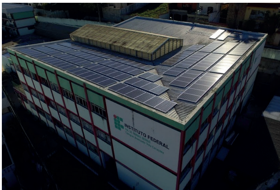
Figura 53 – Prédio principal do Campus Avançado Três Corações
