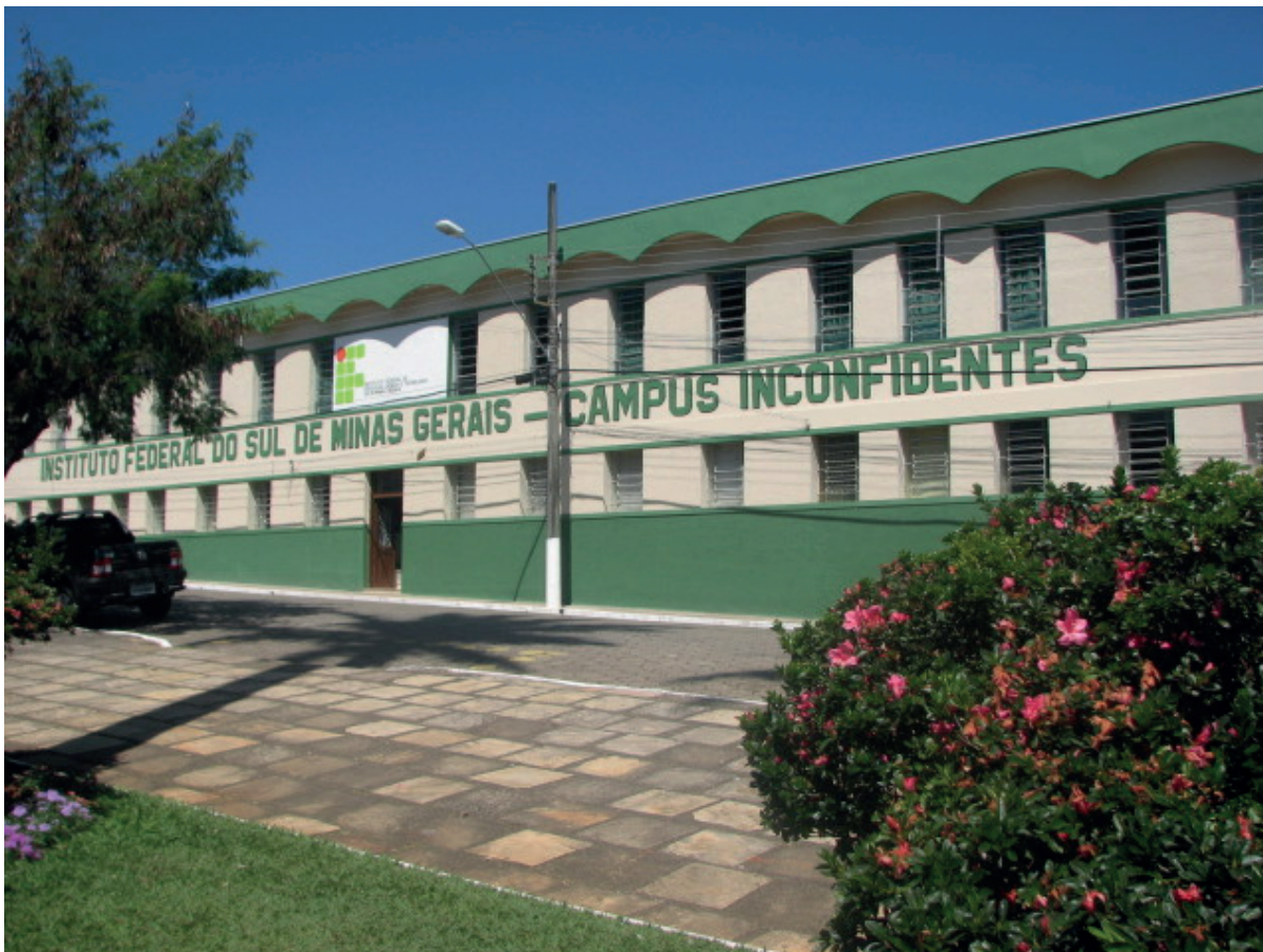
Figura 33 – Prédio principal do Campus no centro de Inconfidentes
