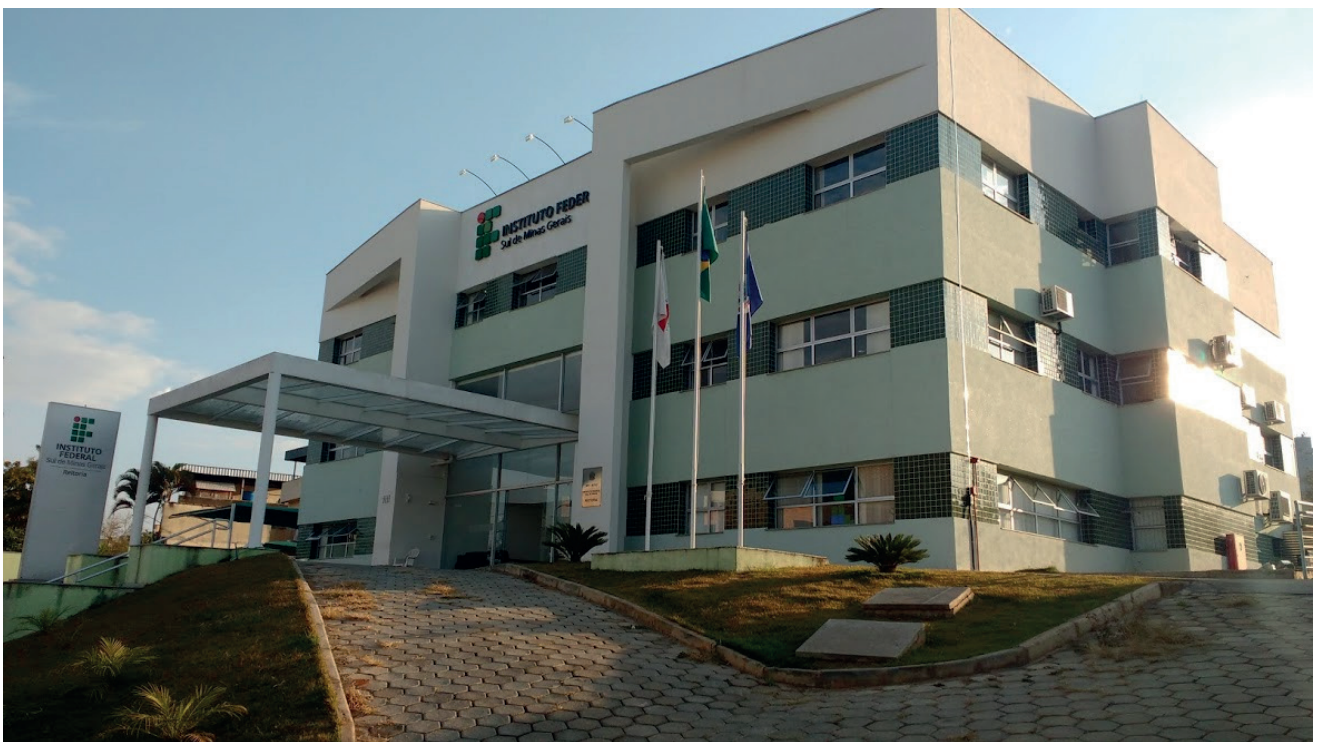
Figura 56 – Vista parcial da Reitoria do IFSULDEMINAS
