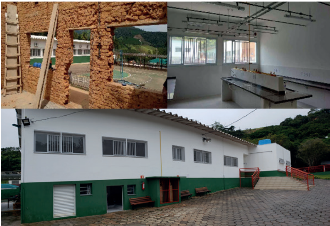
Figura 51 – Laboratório de Alimentos Campus Avançado Carmo de Minas
