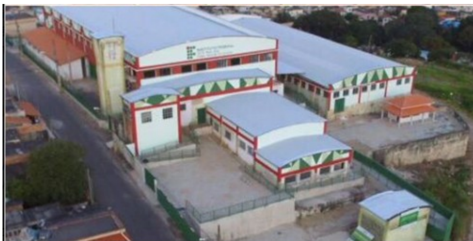
Figura 7 - Novas Instalações do Campus Avançado Três Corações (Campus II). Fonte: Arquivo do Campus.
