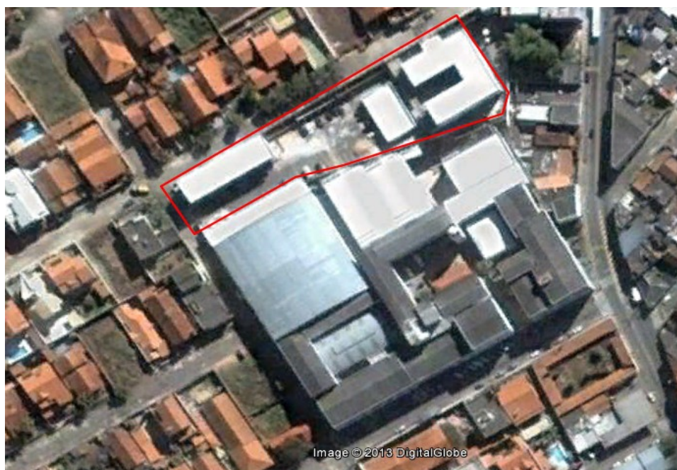
Figura 6 - Vista aérea das instalações do Campus Avançado Três Corações (Campus I)
