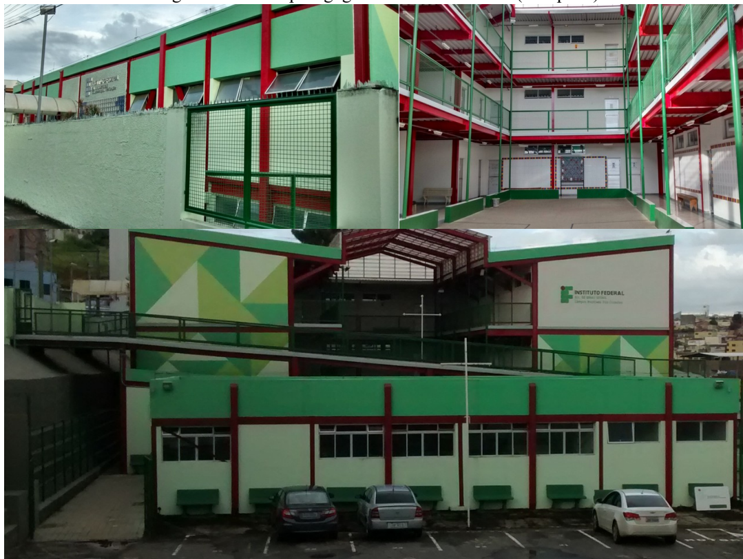
Figura 8 - Blocos pedagógicos e administrativos (Campus I)
