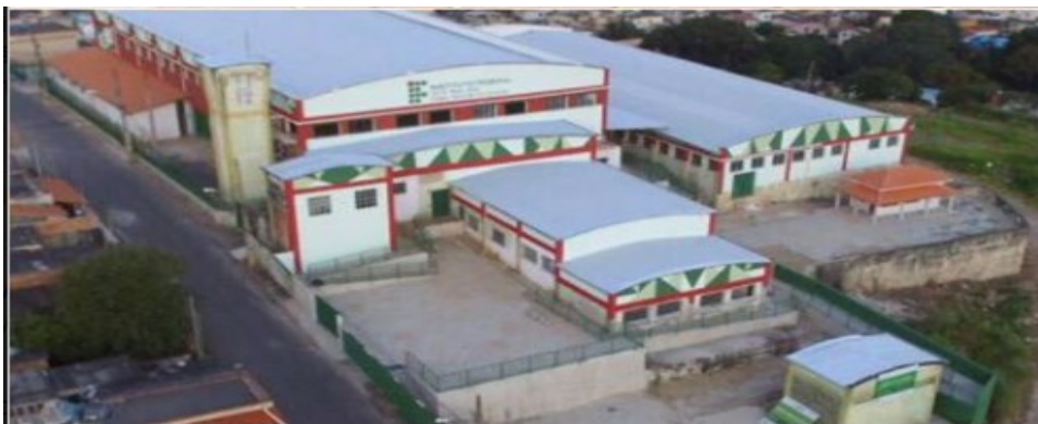
Figura 6 - Novas instalações do Campus Avançado Três Corações - Campus II
