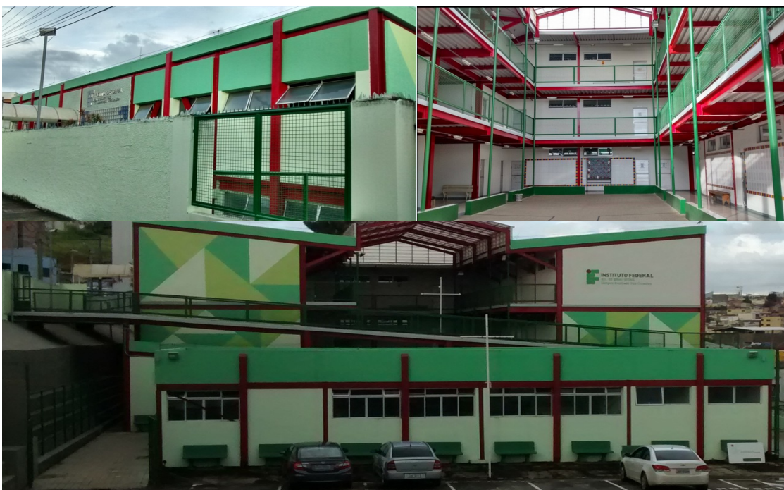
Figura 8 - Blocos pedagógicos e administrativos (Campus I)
