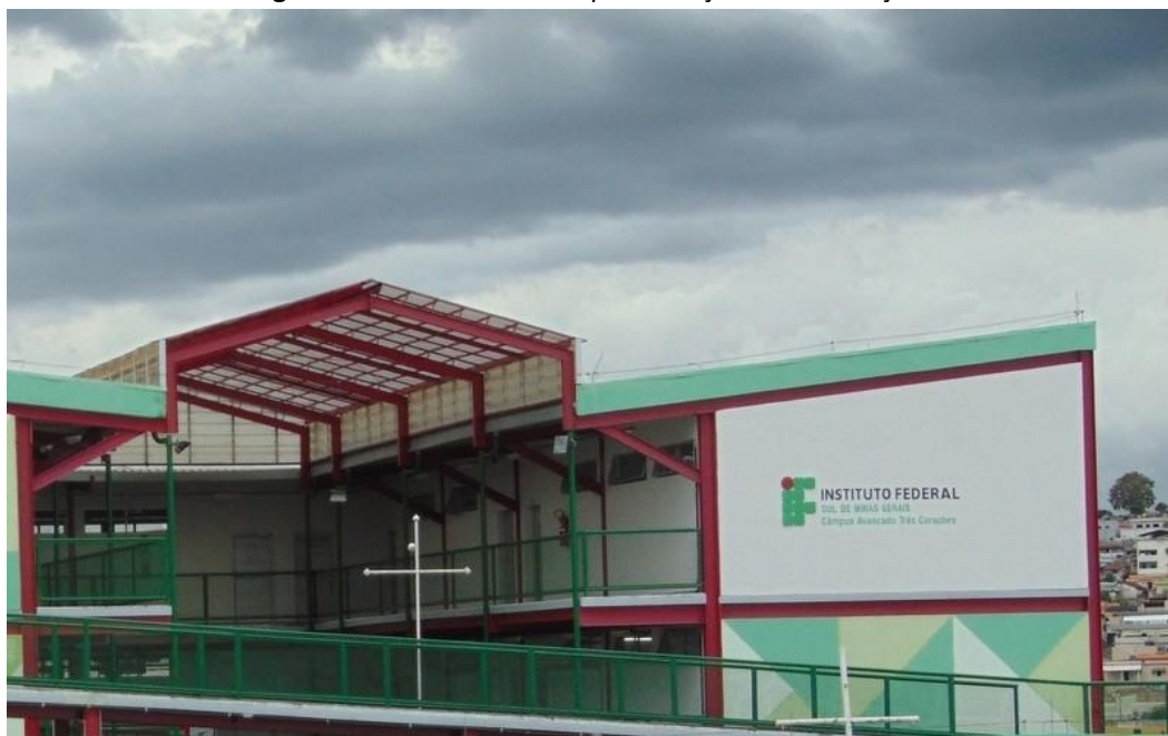
Figura 08 – Fachada do Campus Avançado Três Corações
