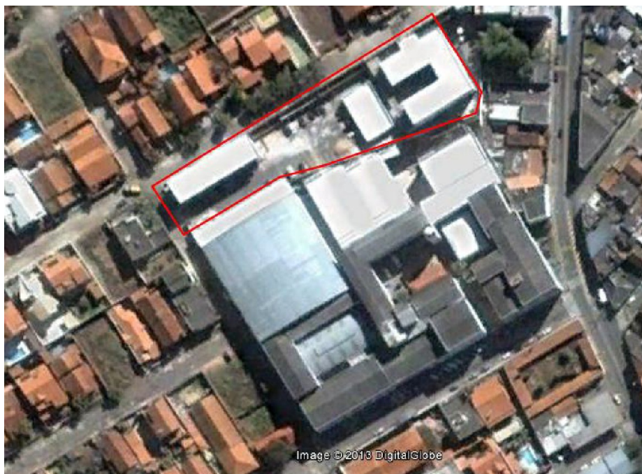
Figura 6 - Vista aérea das instalações do Campus Avançado Três Corações
