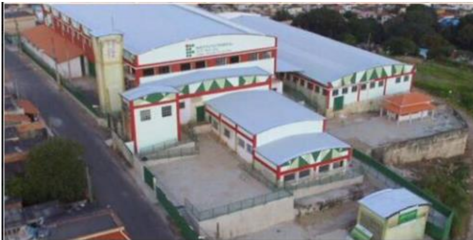
Figura 8 - Novas instalações do Campus Avançado Três Corações (Campus II)
