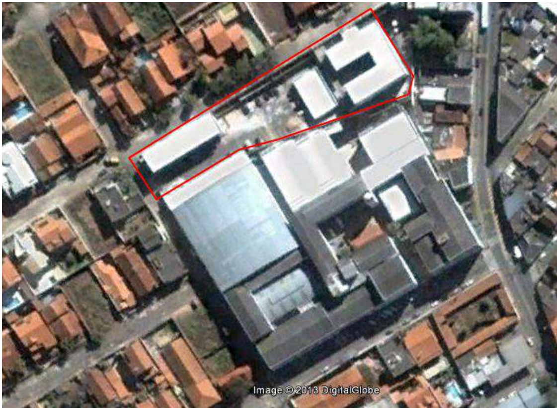
Figura 3: Vista aérea das instalações do Campus Avançado Três Corações
