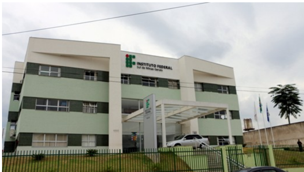
Figura 12 - Fachada do prédio principal da Reitoria do IFSULDEMINAS
