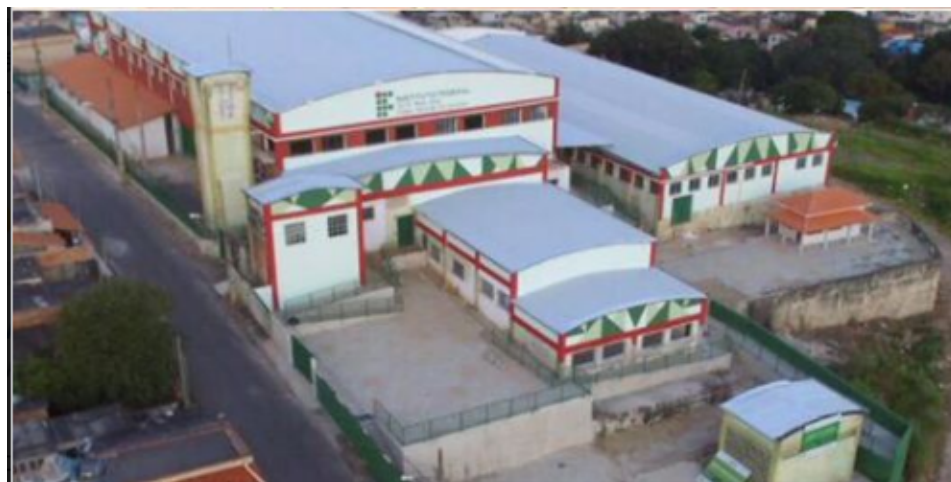
Figura 7 - Novas Instalações do Campus Avançado Três Corações (Campus II)
