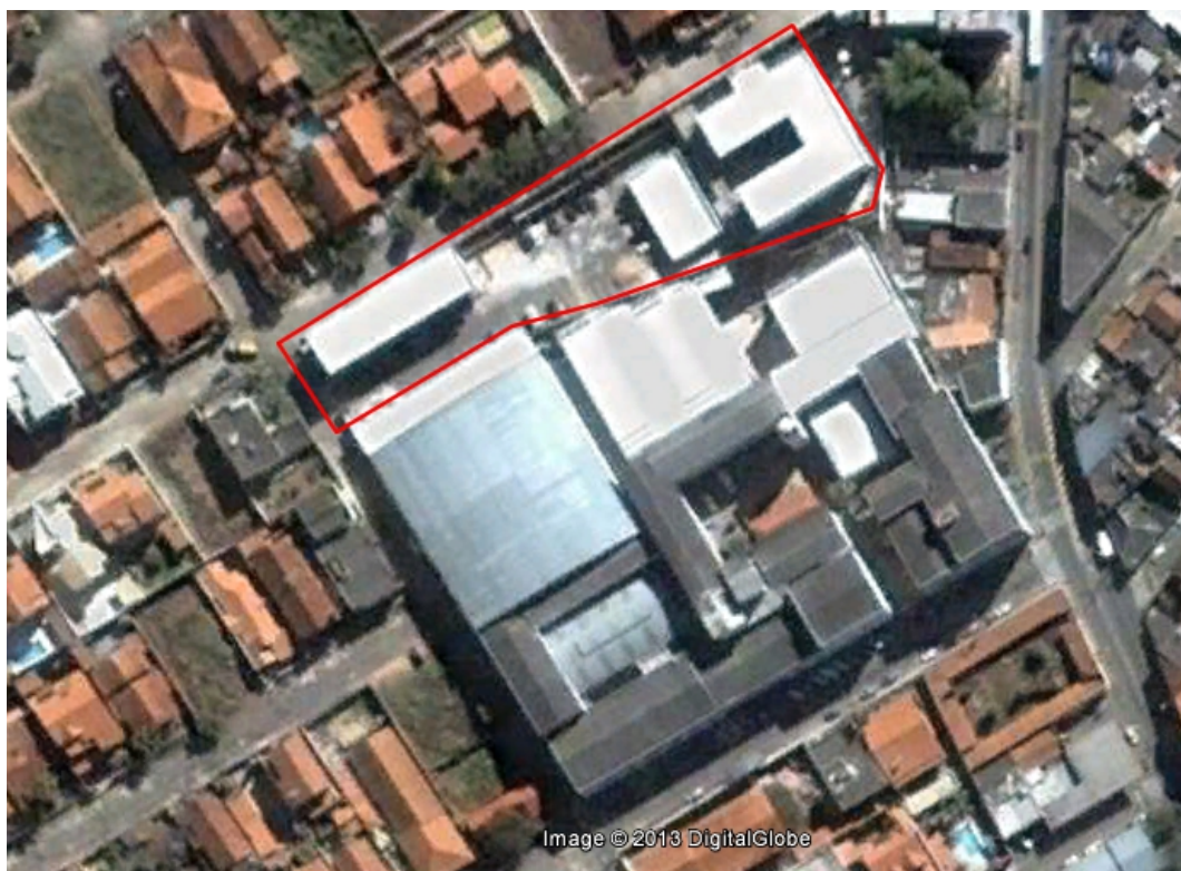
Figura 4 - Vista aérea das instalações do Campus Avançado Três Corações
