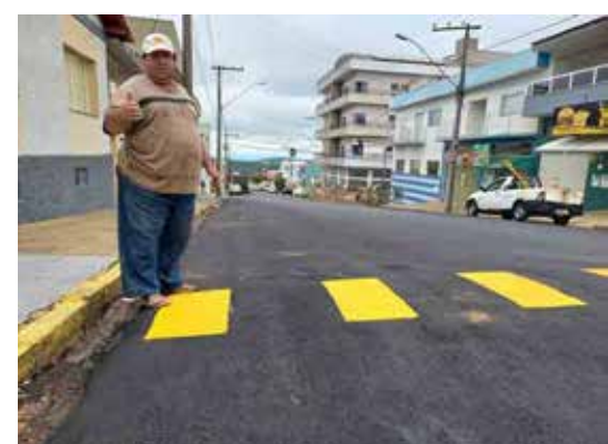
Rua Raul Soares foi recapeada e recebe pintura da sinalização de trânsito
