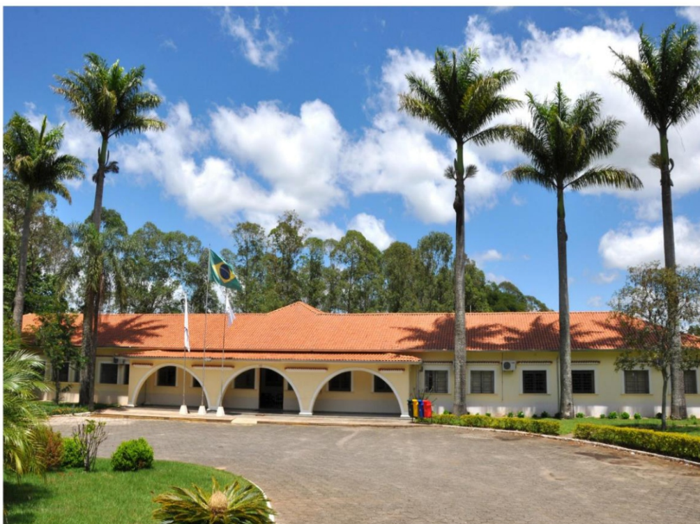
Figura 05 - Prédio Administrativo do Campus Muzambinho
